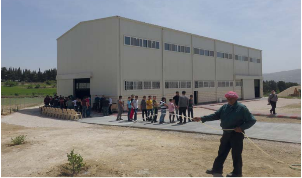
Groß, zweckmäßig und auf die Zukunft hin wurde die neue Schreinerei gebaut.
